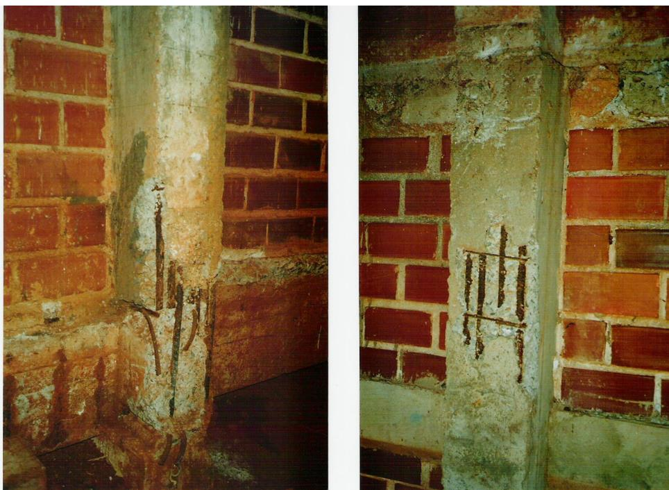
Fig5 – Fotos estudo de caso corrosão por falta de cobrimento adequado.
