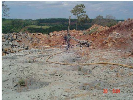
Figura 2: Perfuração da malha de fogo
