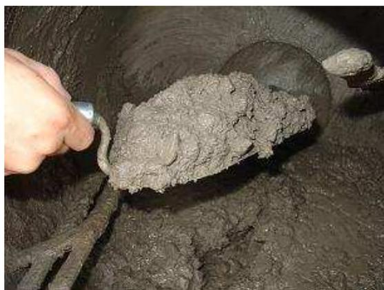
Figura 28: Verificação do teor adequado de argamassa.
